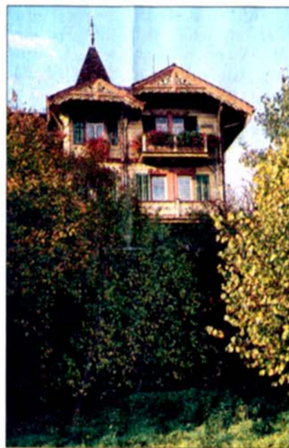
Schmuck Das Pümpin-Haus wurde einer Renovation unterzogen. FOTO: NGL
